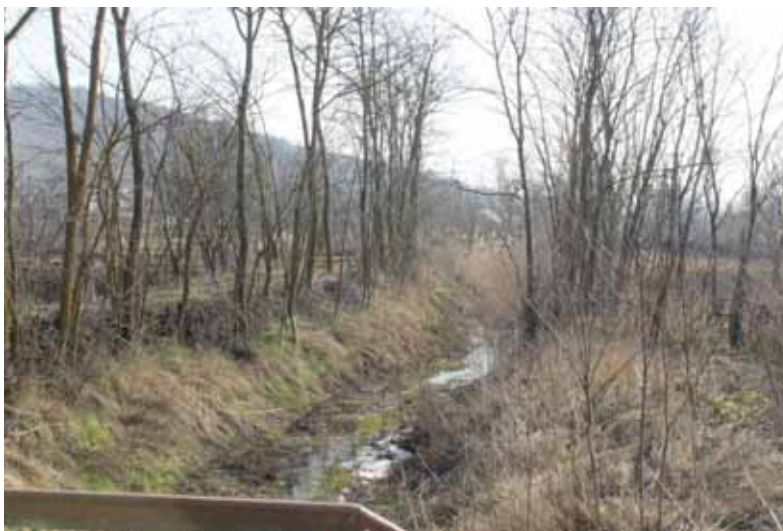
Pârâul Bălțați puternic colmatat și invadat de vegetație
