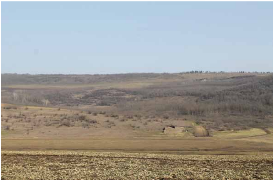
Construcție sezonieră pentru creșterea ovinelor și caprinelor
